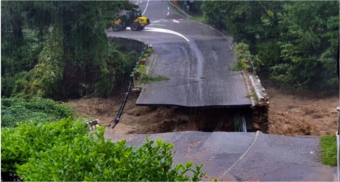
3 Pont emporté par la crue de la Vésubie laissant apparaître la vulnérabilité du regroupement des réseaux (transport, énergie, communications...) ©FBTP06
