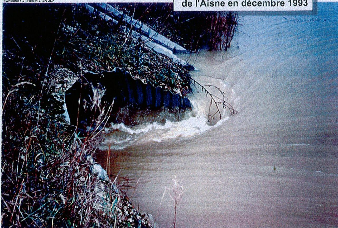
Photo n°11 : l'une des buses de la voie de contournement de la RN 51 (entonnement amont).
