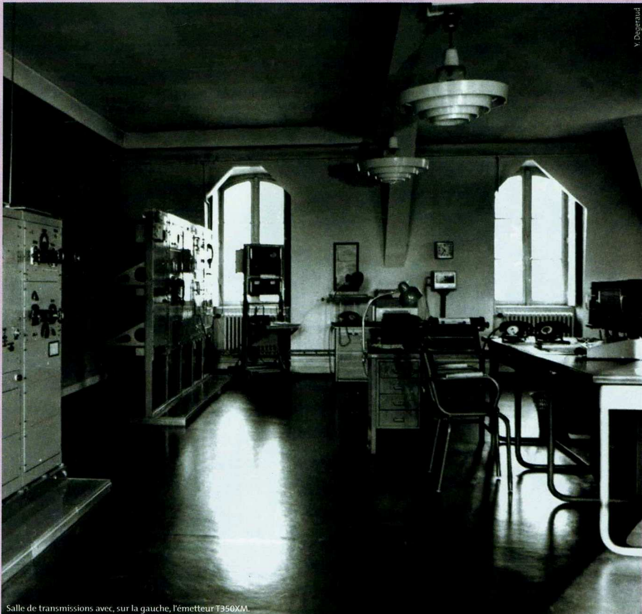
Salle de transmissions avec, sur la gauche, l'émetteur T350XM.
