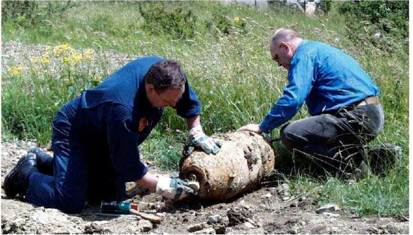
Opérations préparant le désamorçage d'une bombe américaine de 500 livres (125 kilos d'explosif) sur le chantier de construction d'une voie rapide à la frontière allemande en 1999. Ci-dessous, la bombe, sa fusée de culot et sa fusée d'ogive avant désamorçage.
